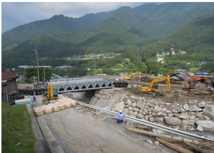
完成した仮橋
