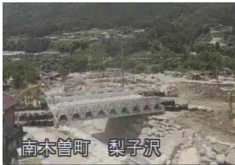
仮橋の架設状況(7/15 15:00現在)
