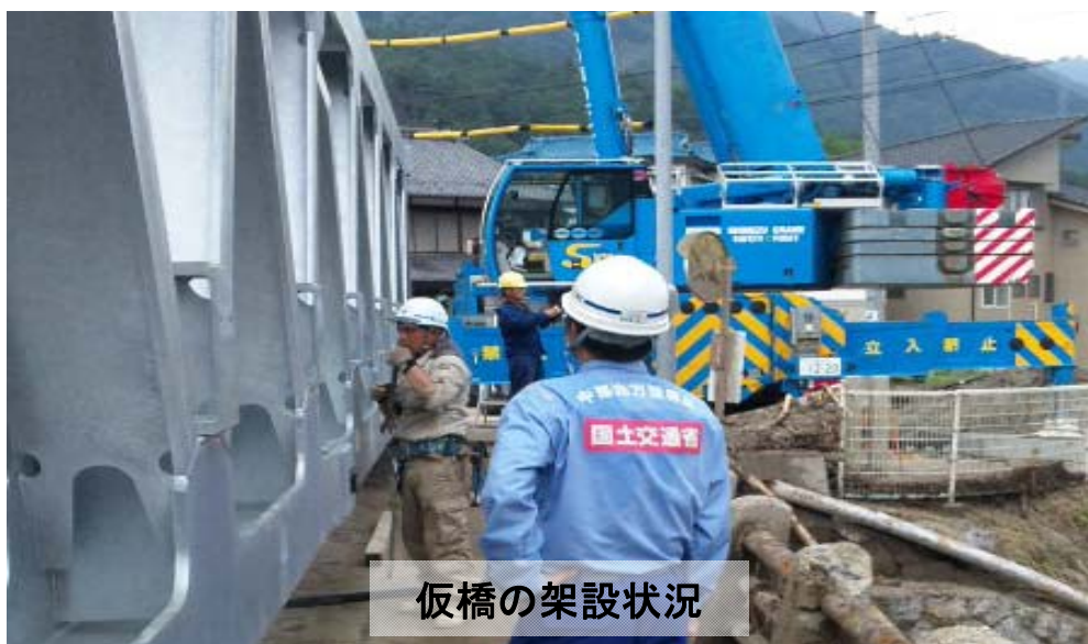
仮橋の架設状況
