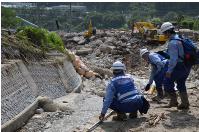
TEC-FORCE隊員による被災状況調査
