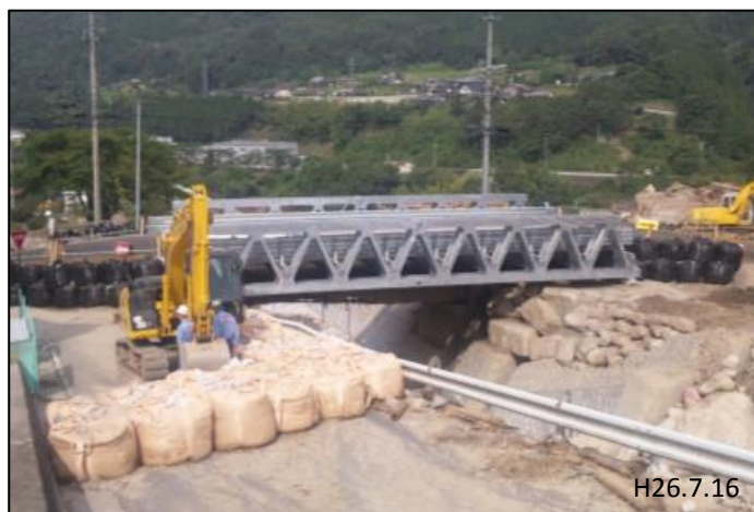
■ 橋梁架設完了
