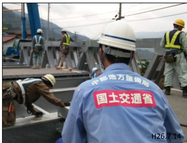
■ 床版パネル設置
