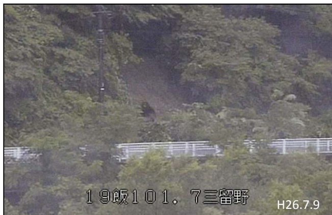
■長野県木曽郡南木曽町読書三留野 国道19号 101.4kp
