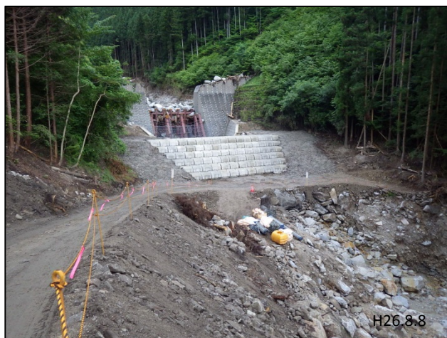
ブロック堰設置状況(梨子沢第1砂防えん堤直下)
