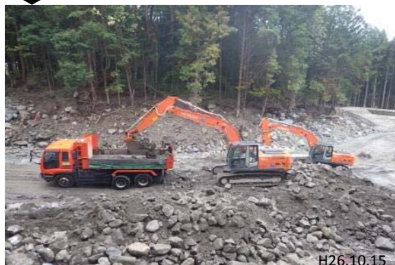
積込搬出作業状況
