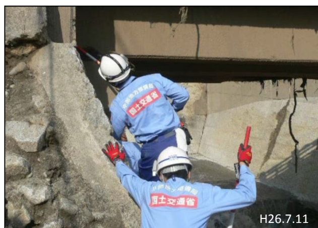
■ 県道264号梨子沢橋の橋梁調査を行うTEC-FORCE隊員
