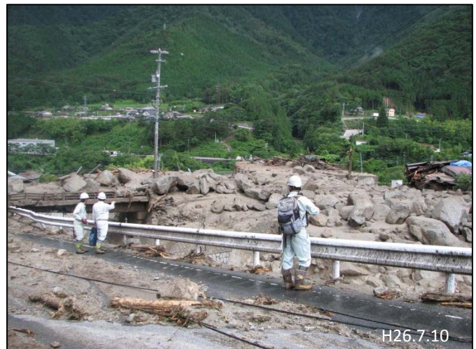
■梨子沢橋右岸 住家被災状況
