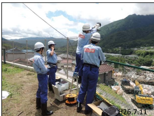
■TEC-FORCE隊員によるWEBカメラの設置
