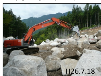
除石作業状況
