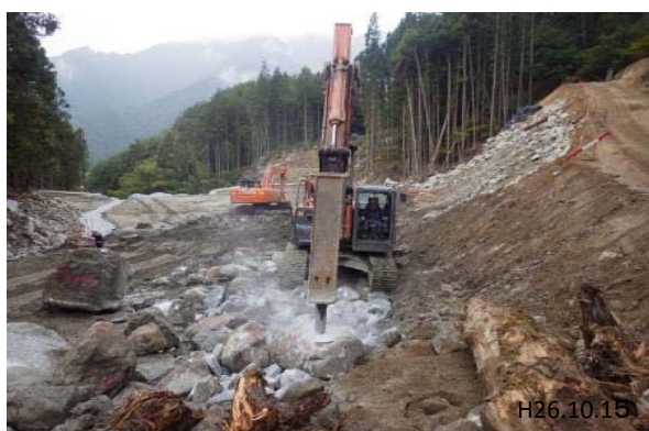
小割作業状況
