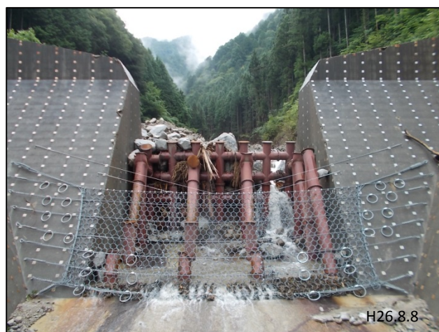
ネット捕捉工設置状況(梨子沢第1砂防えん堤直下)
