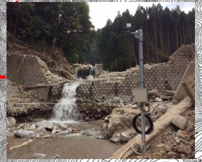
WEBカメラ設置 (梨子沢橋上流、他1箇所)
