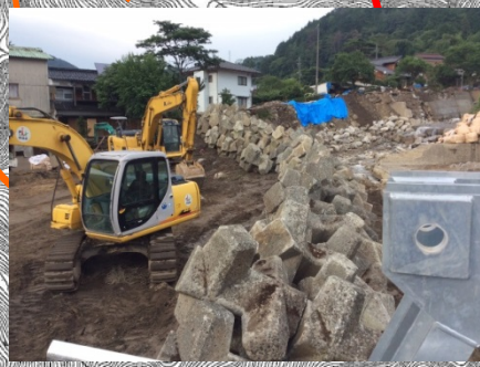
応急復旧用ブロック設置
