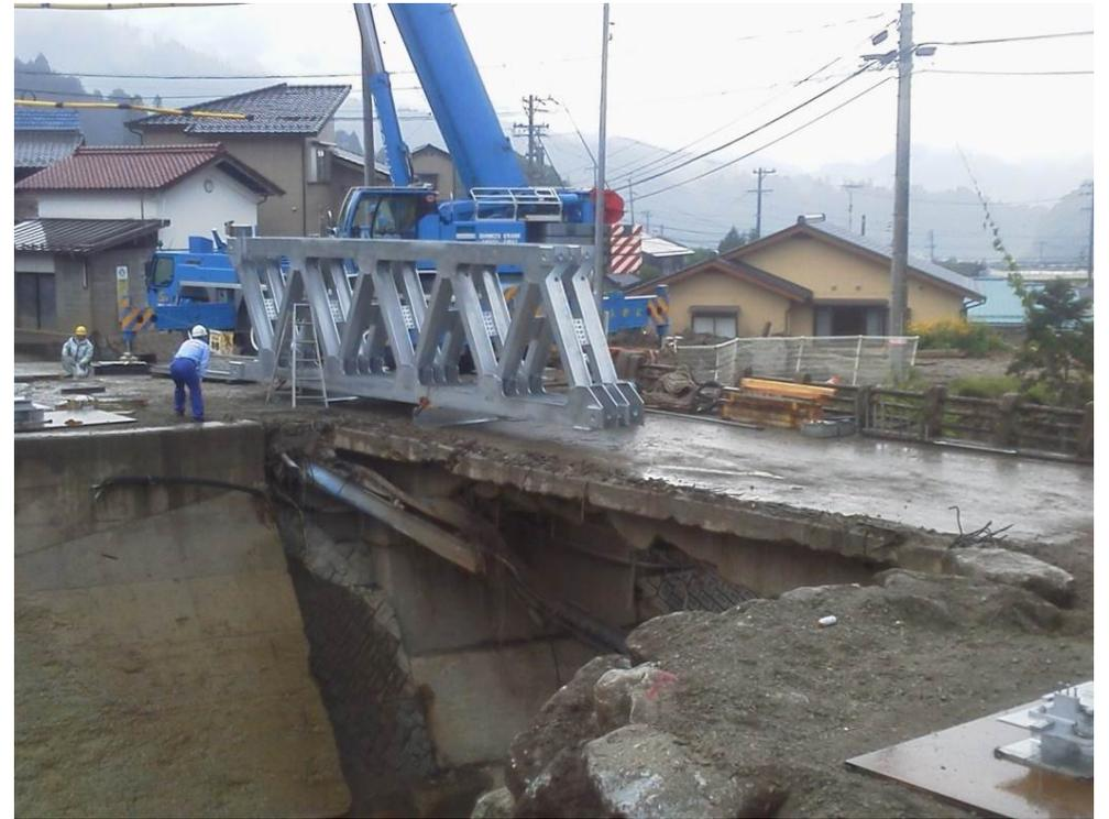
④トラス主桁組立状況(7月13日 15:00撮影)
