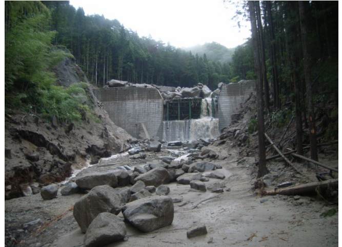
梨子沢第2砂防堰堤（国交省）【大梨子沢】
