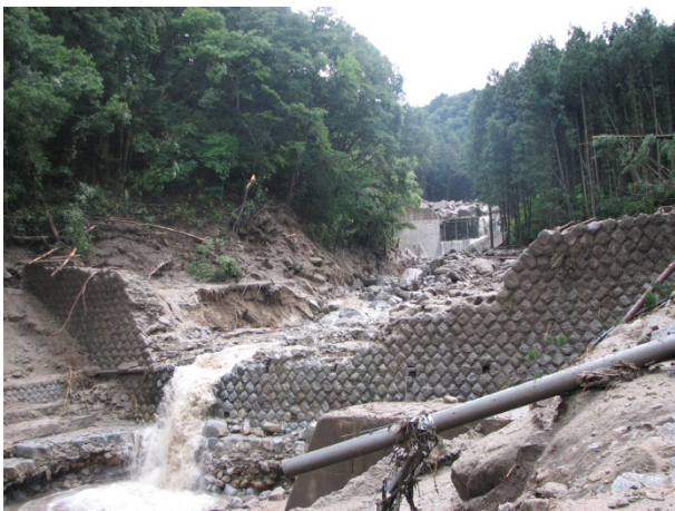
CCTVが設置されていた落差工（長野県）
