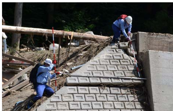
現地調査状況写真（昨日の様子）
