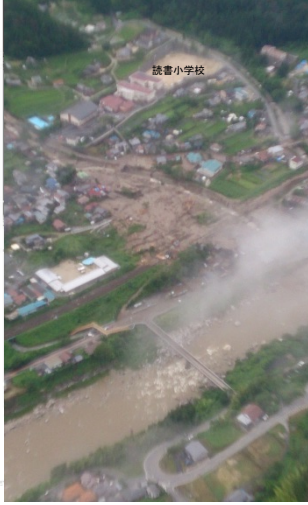
<土砂流出状況写真>
