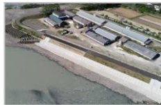
堤防整備 (宮田村 大久保地区)
