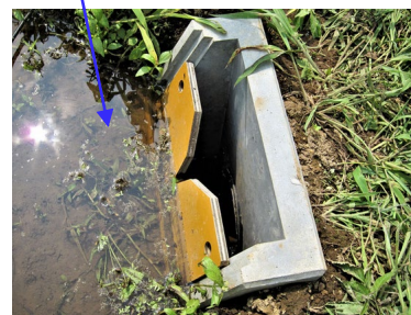
水位調整板の設置イメージ
