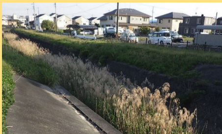
河道掘削(除草)前の状況
