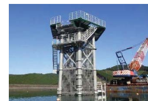
取水設備の整備
