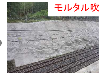
鉄道に隣接する斜面 法面補強工
