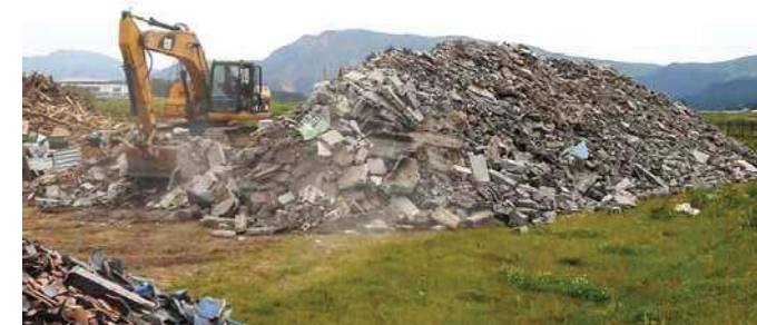
熊本地震の際の廃棄物仮置き場 (出典: 環境省HP『災害廃棄物対策フォトチャンネル』)
