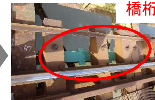
鉄道河川橋りょう 橋桁の補強補修工
