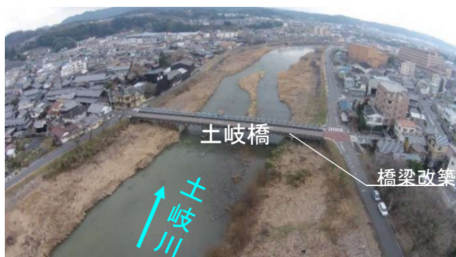
改築予定橋梁 (瑞浪市)
