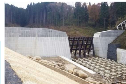
＜鍛冶ヶ入川第5砂防堰堤＞ 砂防施設の整備(多治見砂防国道事務所)
