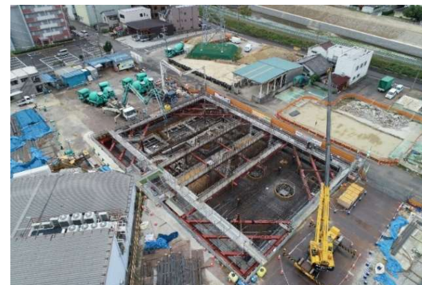
地蔵川排水機場の整備(愛知県)
