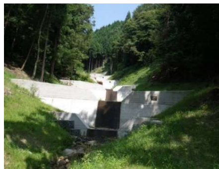
治山堰堤(瑞浪市)
