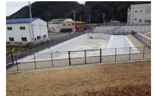
雨水貯留施設(多治見市)
