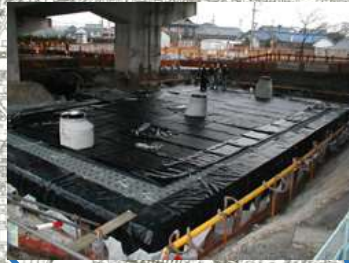
雨水貯留施設整備
