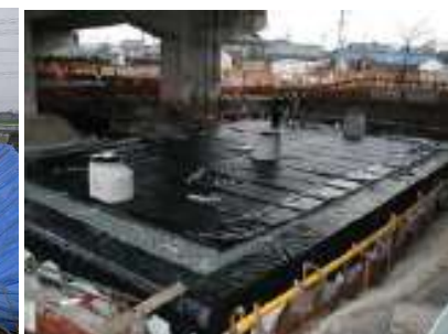
雨水貯留施設の整備 (大治町)
