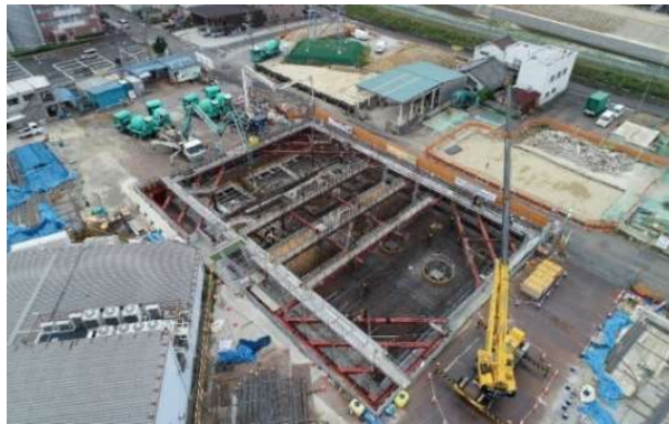
地蔵川排水機場の整備状況（愛知県）
