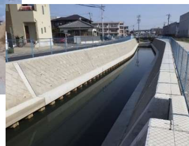
堤防整備(一宮市(準)千間堀川)
