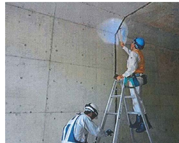
写真 近接目視による点検状況 （大型カルバート）
