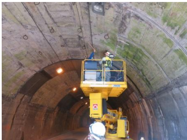
高所作業車による近接目視点検
