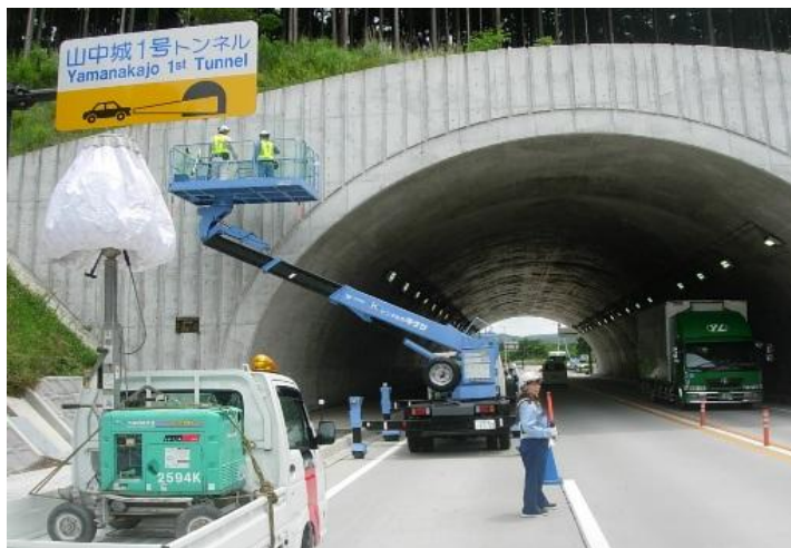
高所作業車による近接目視点検
