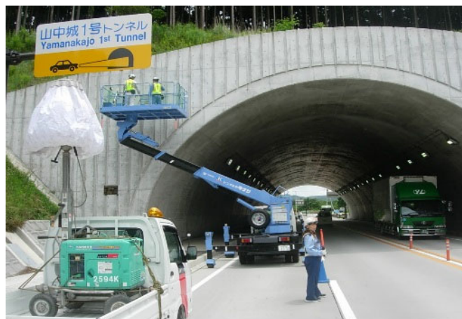
高所作業車による近接目視点検
