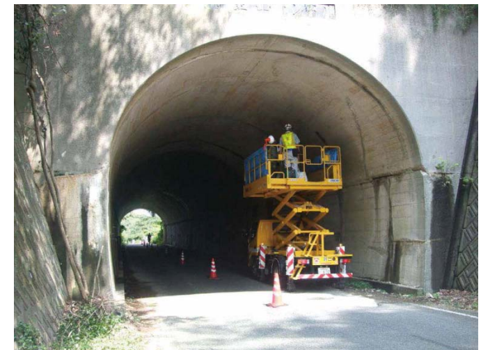
写真 近接目視による点検状況
