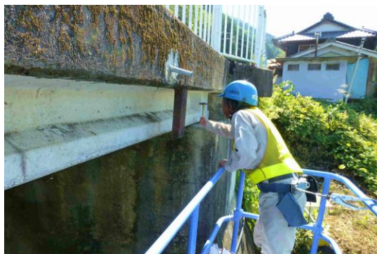
打音検査によるウキ等の調査
