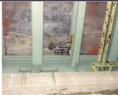
鋼部材、床版の劣化
