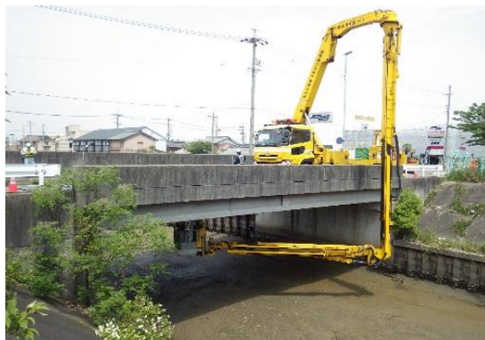
橋梁点検車による近接目視点検
