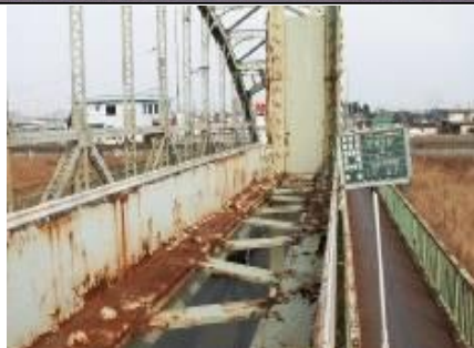
鋼部材、床版の劣化
