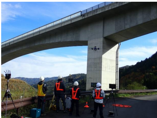
ドローン点検(国道158号 殿地橋)
