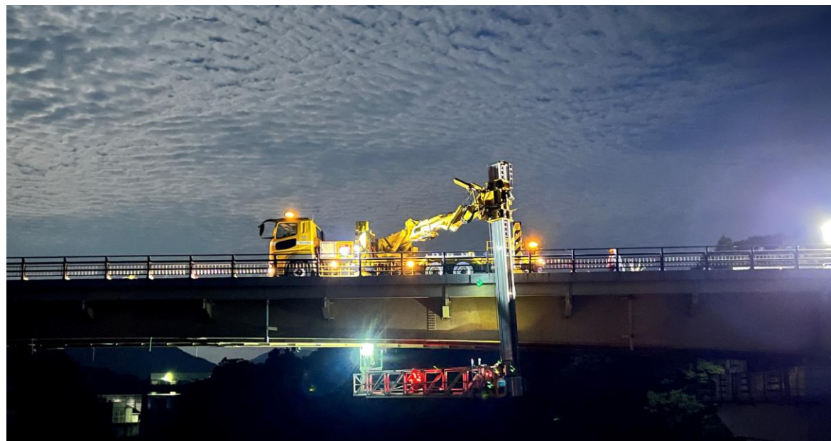
橋梁点検車で橋を真下から点検
