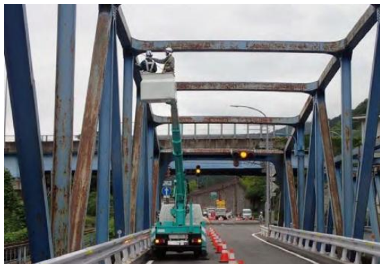
高所作業車による近接目視点検
