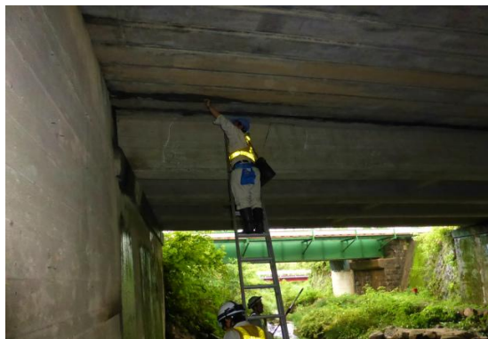
触診による劣化状況の調査
