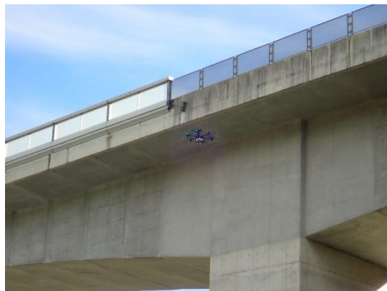
ドローン点検(国道158号 殿地橋)
