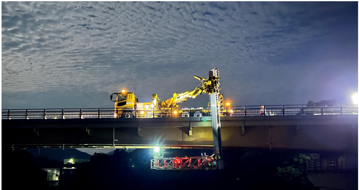
橋梁点検車で橋を真下から点検
