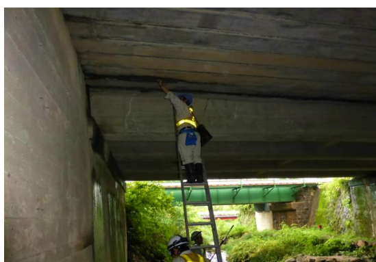
触診による劣化状況の調査
