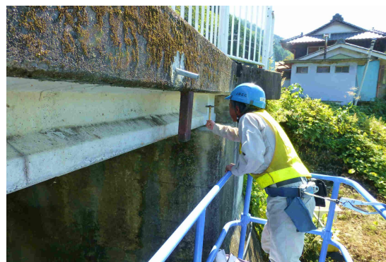
打音検査によるウキ等の調査
