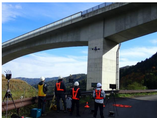
ドローン点検(国道158号 殿地橋)
