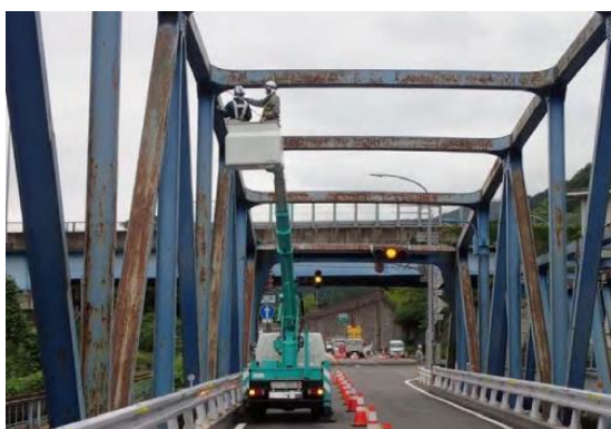
高所作業車による近接目視点検
