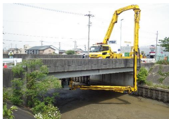
橋梁点検車による近接目視点検
