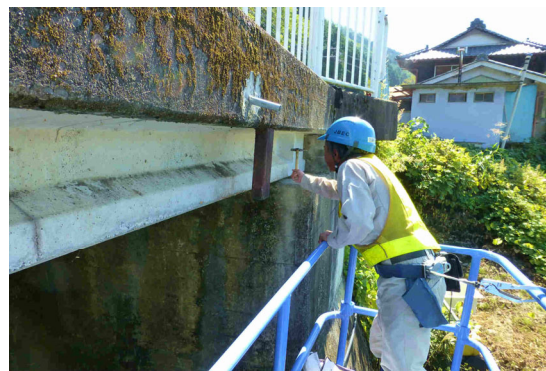
打音検査によるウキ等の調査
