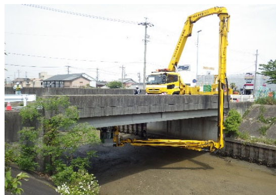
橋梁点検車による近接目視点検
