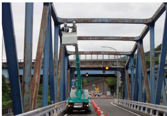
高所作業車による近接目視点検
