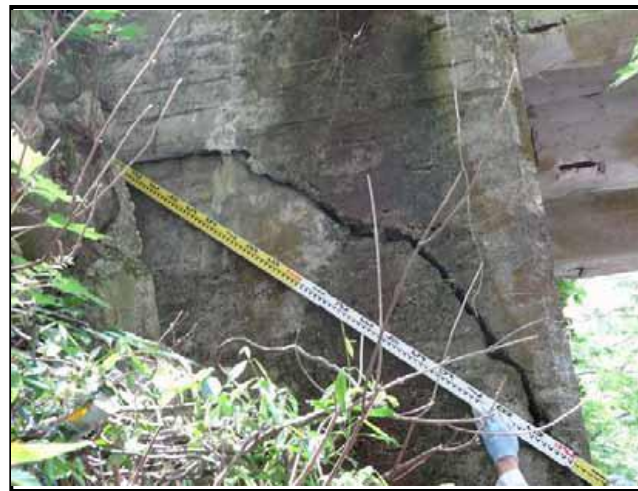
橋台の損傷
