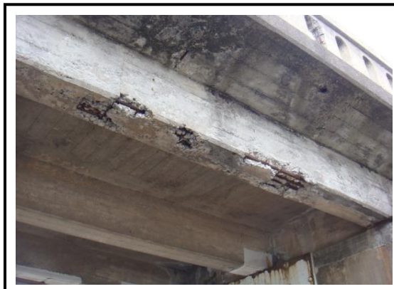
主桁の損傷
