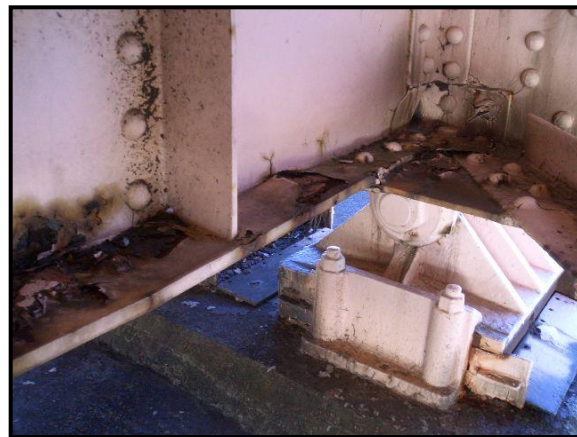
横桁の損傷
