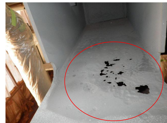
トラス格点部（下弦材上フランジ）の損傷
