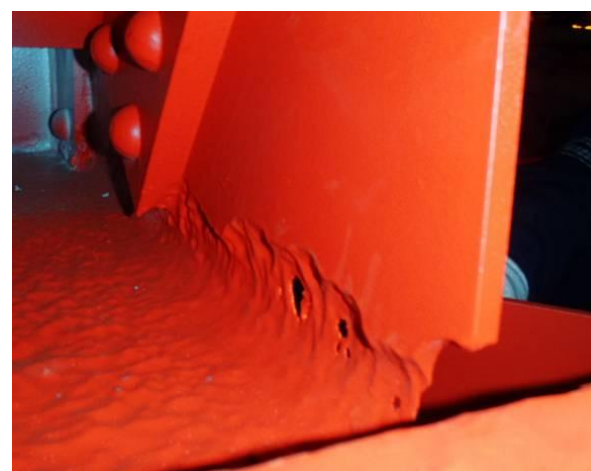
トラス格点部（ガセット）の損傷
