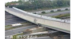
熊本地震で落橋したロッキング橋脚構造の橋
