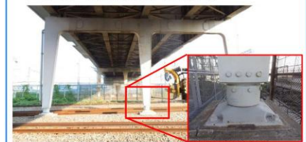
熊本地震で落橋したロッキング橋脚構造の橋
