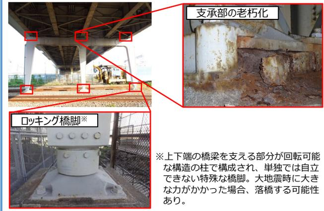
※上下端の橋梁を支える部分が回転可能な構造の柱で構成され、単独では自立できない特殊な橋脚。大地震時に大きな力がかかった場合、落橋する可能性あり。
