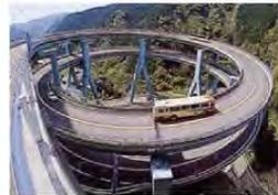
高低差45mを二重の螺旋カーブで結ぶ河津七滝ループ橋(R=40m)
