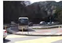
速度低下を生じさせるヘアピンカーブ(R=25m)
