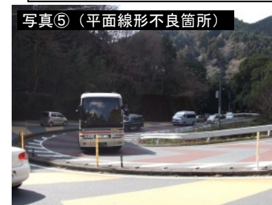
速度低下を生じさせるヘアピンカーブ (R=23m)
