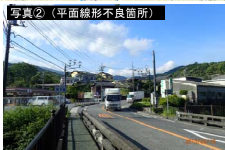
カーブ (R=40m) で車線をはみ出し走行する大型車
