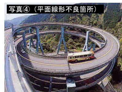
高低差45mを二重の螺旋カーブで結ぶ河津七滝ループ橋 (R=40m)
