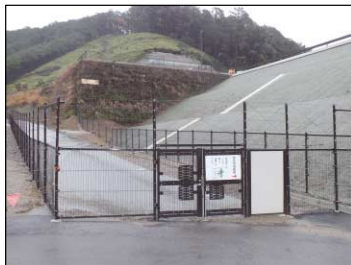
6. 紀伊長島区三浦(新道瀬トンネル尾鷲側坑口)
