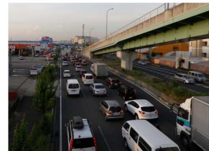
▲国道41号 ≪村中交差点付近≫
