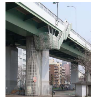
図 避難階段（高架部）イメージ写真
