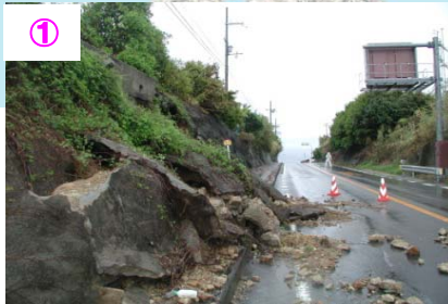
豪雨による法面崩落状況(和深付近)
