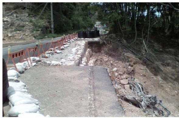
迂回路として想定している県道は2車線整備されているが、台風12号で被災した箇所があり、現在においても、片側交互通行を行っている。
