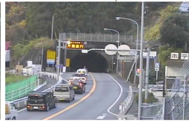
大泊地区と熊野市街地を結ぶ道路は鬼ヶ城トンネルしかなく、事故等により本トンネルが通行止めとなった場合代わりとなる道路がない。
