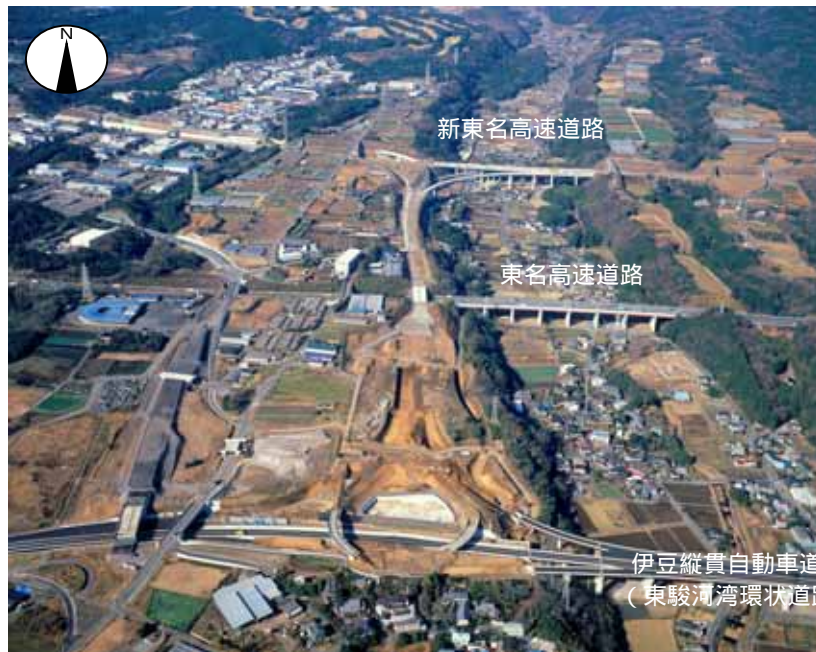
伊豆縦貫自動車道 長泉JCT付近 (H22.1)
