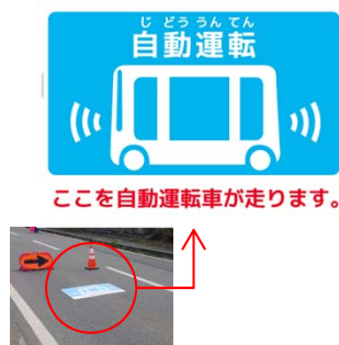
路面標示の設置
