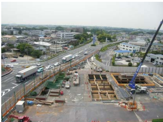
(a) 土留め工
