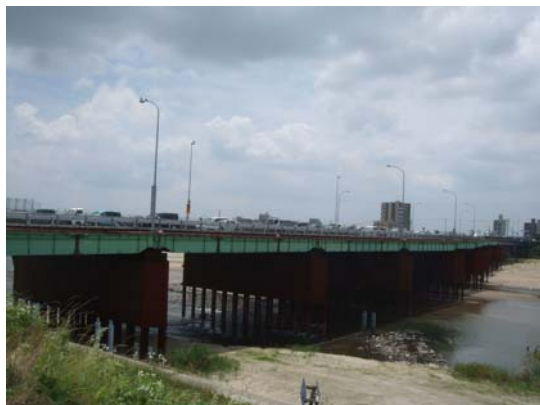
(b) 仮栈橋工
