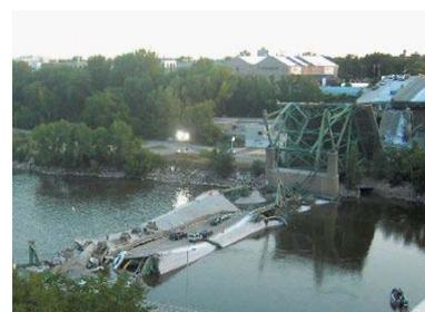
写真-11-II-2 米国ミシシッピ川橋梁が落橋した状況
