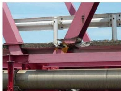
写真-11-II-1 木曽川大橋の斜材破断の状況
