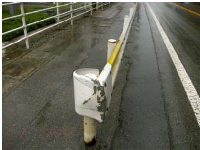
写真-11-I-1 防護柵の損傷事例
