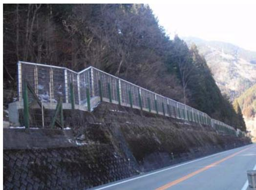
写真-10-I-4 高エネルギー吸収落石防護柵設置状況
