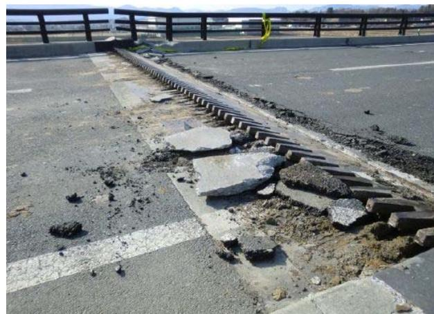
写真-10-I-2 ジョイントの損傷事例
