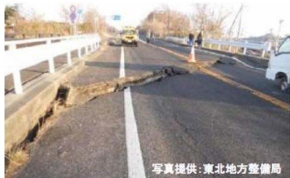
写真-10-I-1 踏掛板がなく車道部に段差が生じた事例<sup>1)</sup>
