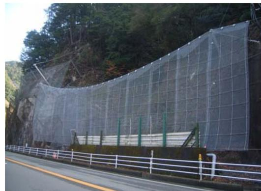
写真-10-I-5 高エネルギー吸収落石防護網設置状況
