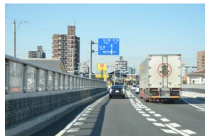
写真-9-I-5 音源の近くへ遮音壁を設置した例
