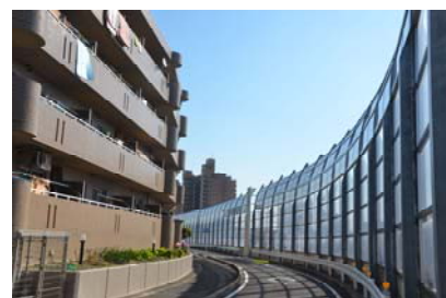
写真-9-I-4 透光板を用いた例
