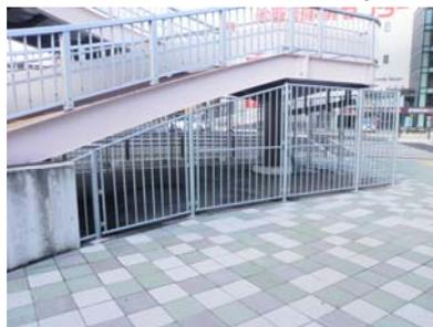
写真-8-III-1 立入防止柵設置事例 (参考)
