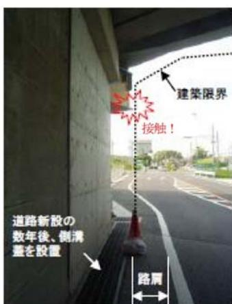
図-8-II-4 側溝蓋を設置した事により、車両が構造物に接触する可能性が生じた事例
