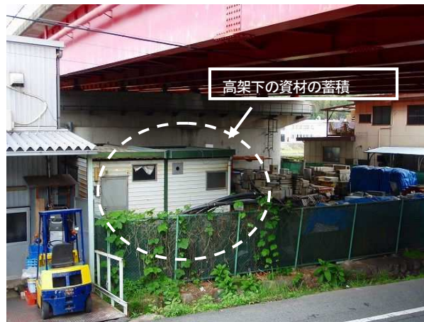
写真-5-Ⅲ-6 高架下に資材を蓄積しリフト車点検ができない例
