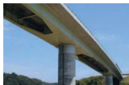
写真-5-II-5 複合ラーメン橋
