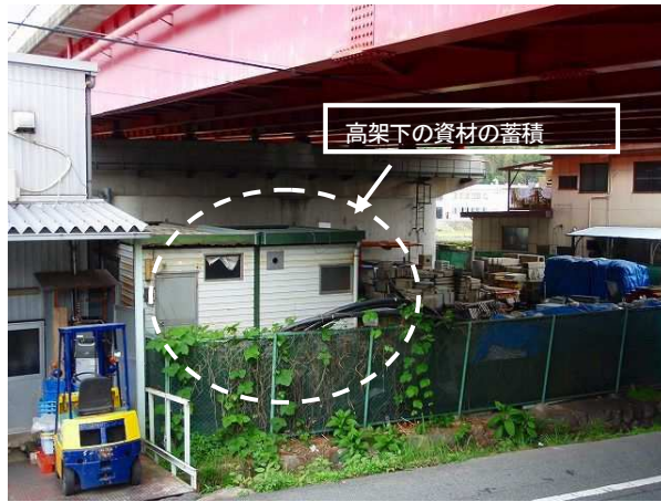
写真-5-III-6 高架下に資材を蓄積しリフト車点検ができない例
