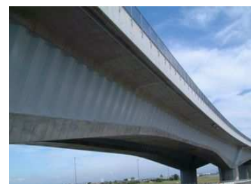
写真-5-II-4 波形鋼板ウェブ橋
