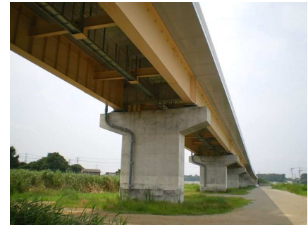
写真-5-II-2 少数主桁橋
