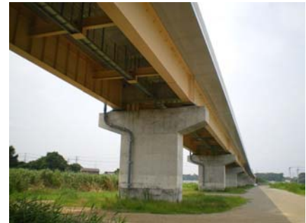
写真-5-II-1 少数主桁橋
