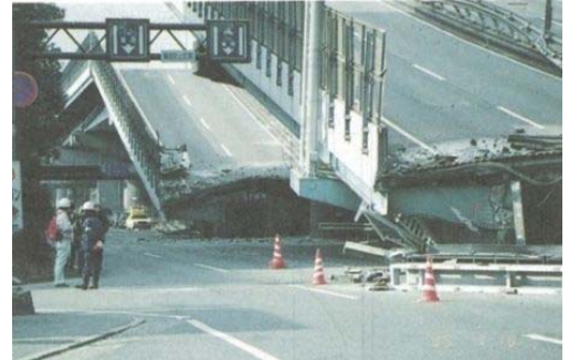
写真-5- I-1 単純桁の落橋
