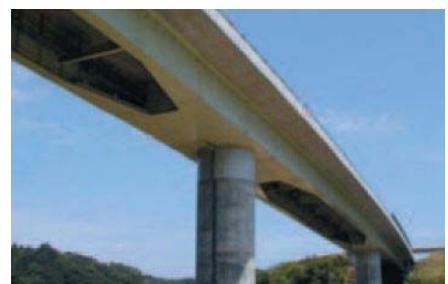
写真-5-II-2 複合ラーメン橋
