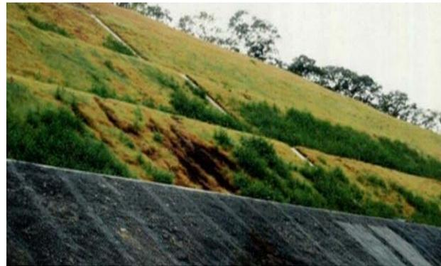
写真-2-II-2 黄鉄鉱に起因する法面の酸化
