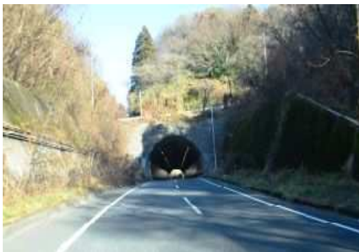
(a)トンネル坑口にて
