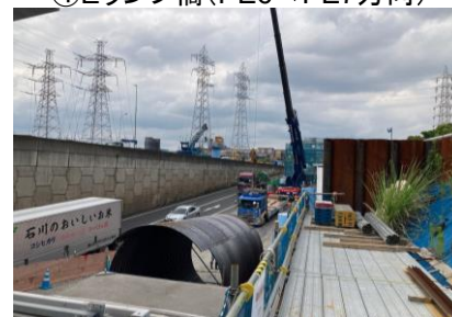
④Eランプ橋(PE6→PE7方向)
