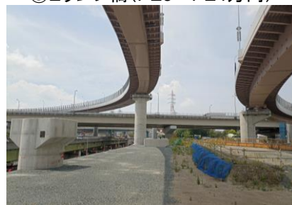
③Eランプ橋(PE3→PE4方向)
