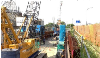
⑦荒尾地区道路(起点→終点)
