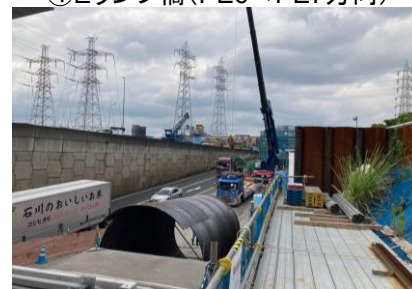
④Eランプ橋(PE6→PE7方向)
