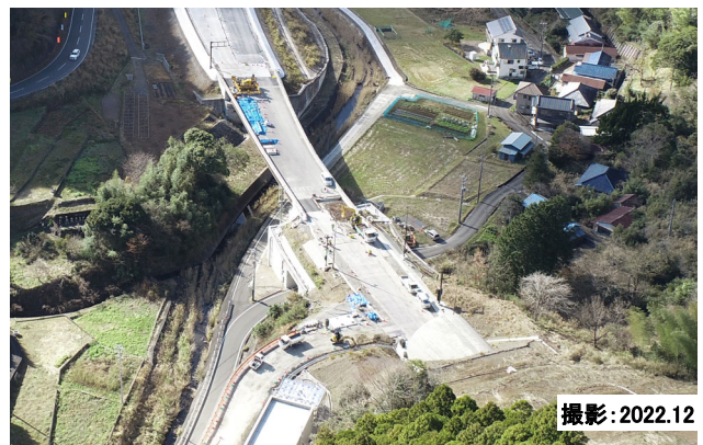
かわづ さかさかわ ばし 【河津逆川橋】
