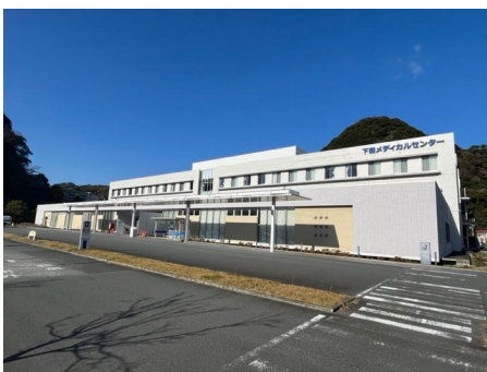
下田メディカルセンター
