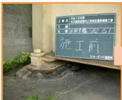
【補修前（支保の腐食）】
