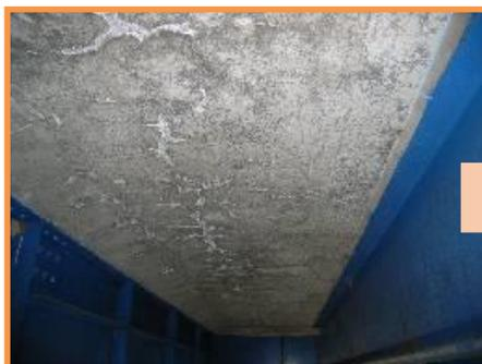
【補修前（床版コンクリートひびわれ）】
