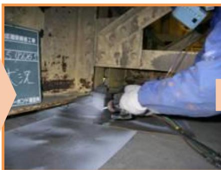
【補修状況（支保防錆処理）】
