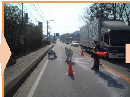
【補修作業状況（補修材注入）】
