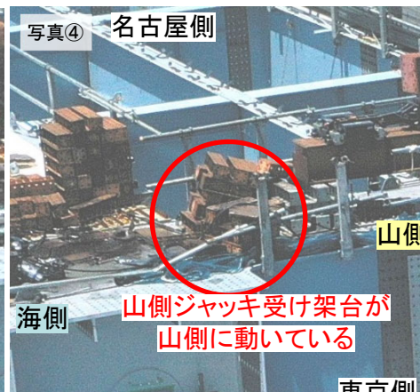
山側ジャッキ受架台は山側に移動
