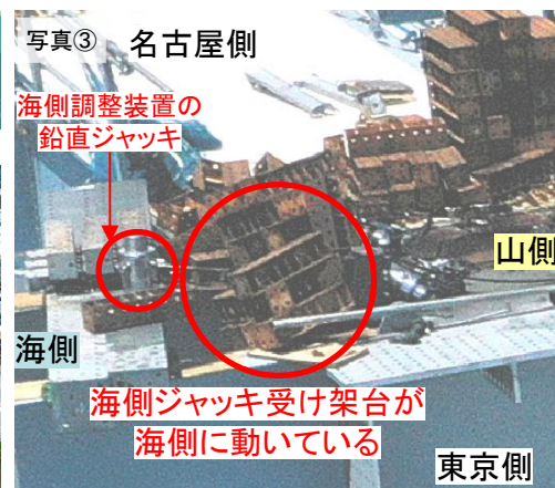
海側ジャッキ受架台が海側に移動
