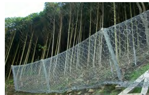
高エネルギー吸収型落石防護柵
