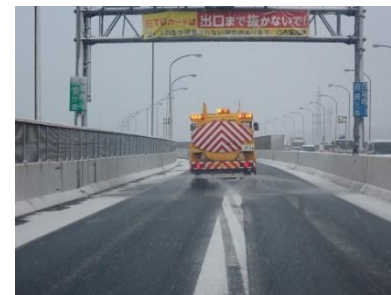
溶液散布の状況（本線部）
