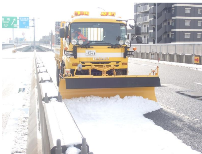
名古屋高速道路の除雪状況
