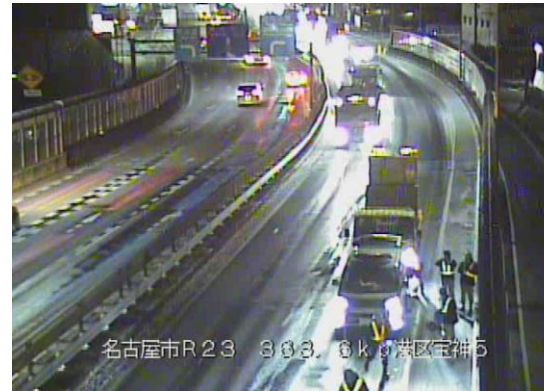
国道23号庄内新川橋（渡河部の橋梁）
